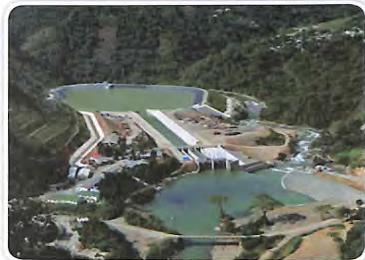
Foto de la represa en Juá Chajul de la Hidroeléctrica Hidro Xacbal del grupo Terra
