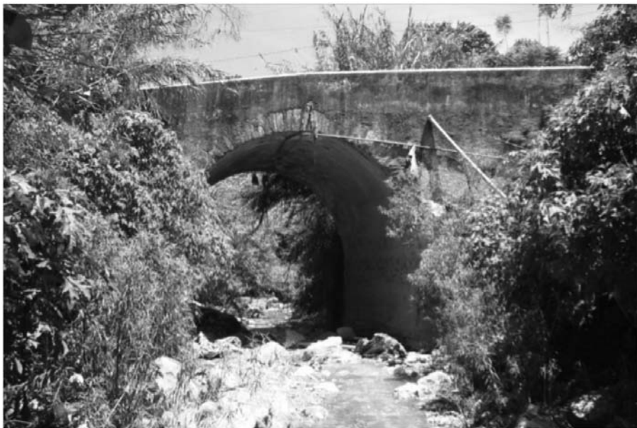
Puente La Cruz, construido por medio de trabajo forzado Archivo CEDFOG
