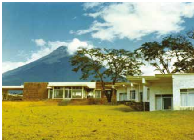
Figura No. 41 Instalaciones del Centro de Apostolado Seglar (C.A.S) “Emaús” en Palín, Escuintla
