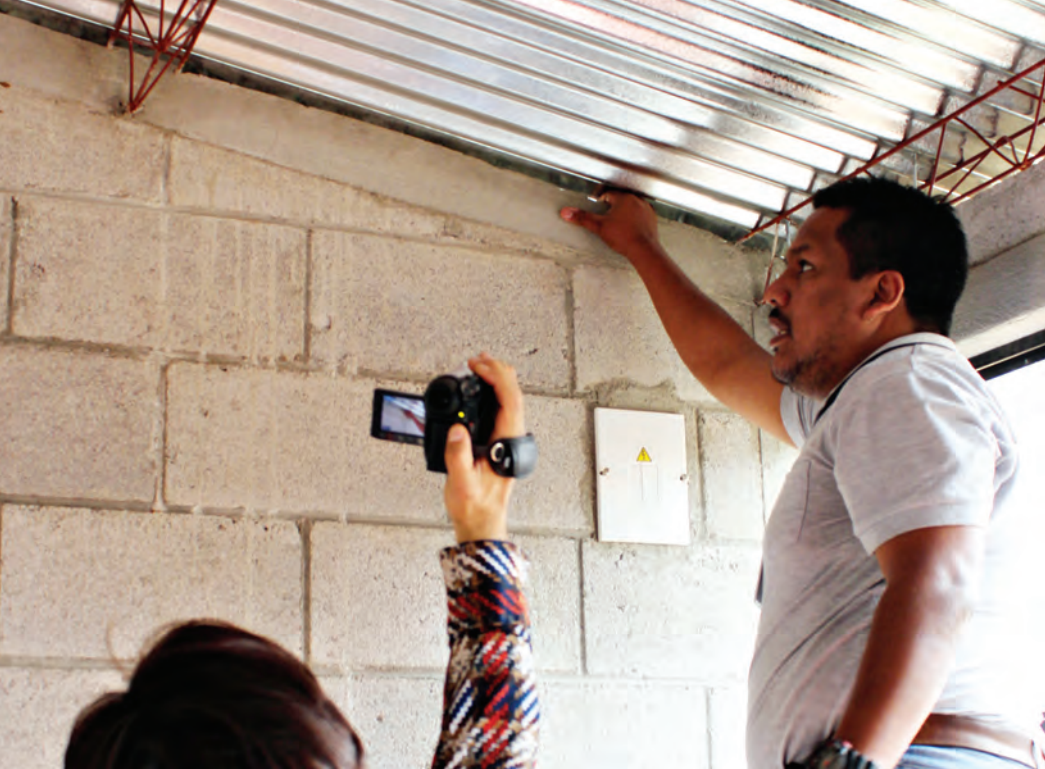
Evaluación de viviendas construidas antes del 2012 en Zaculeu, Tecpán, Chimaltenango. 17-02-2012
