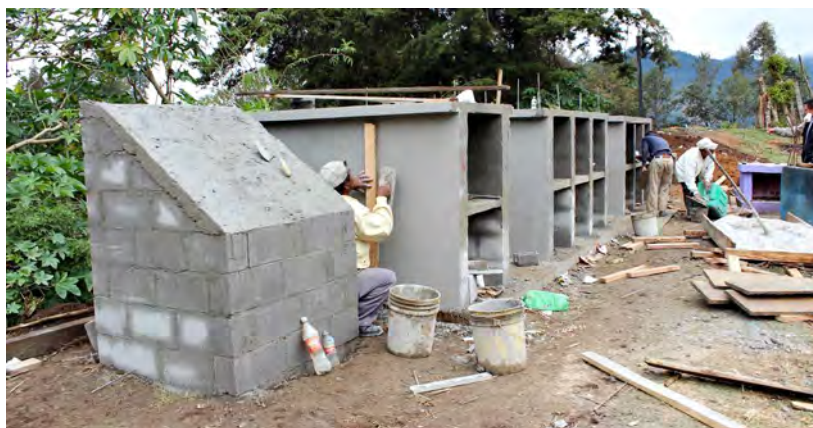
Construcción y supervisión de nichos para inhumación en Nebaj, Quiché. 22-12-12
