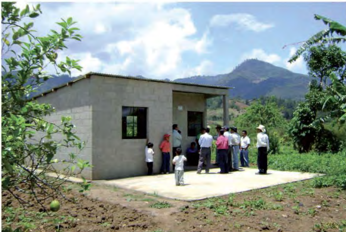
Restitución material de vivienda en Uspantán, Quiché, el 9 de mayo.
